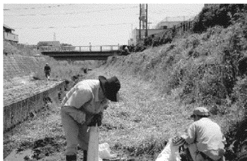
↑河川敷での作業風景
